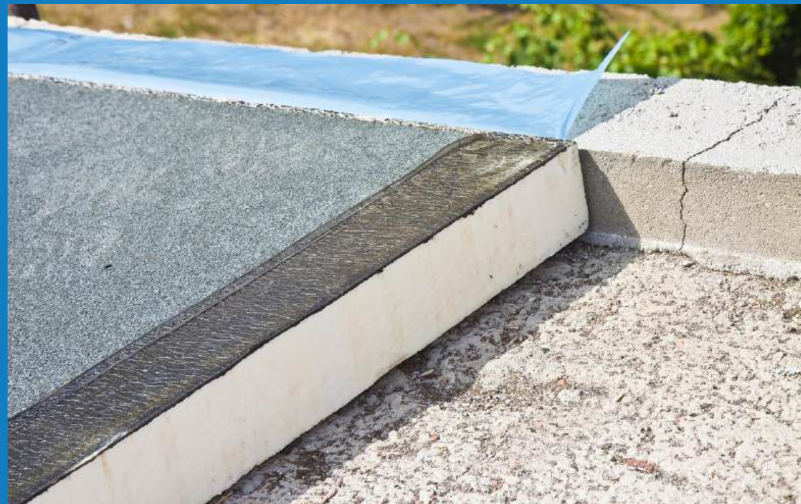
Plat dak: altijd isoleren van buitenaf
