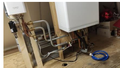
Figuur 1 Installatiedetail van een hybride systeem: rechts de gasketel, links de warmtewisselaar (binnen-deel) van de Lucht-Water Warmtepomp
